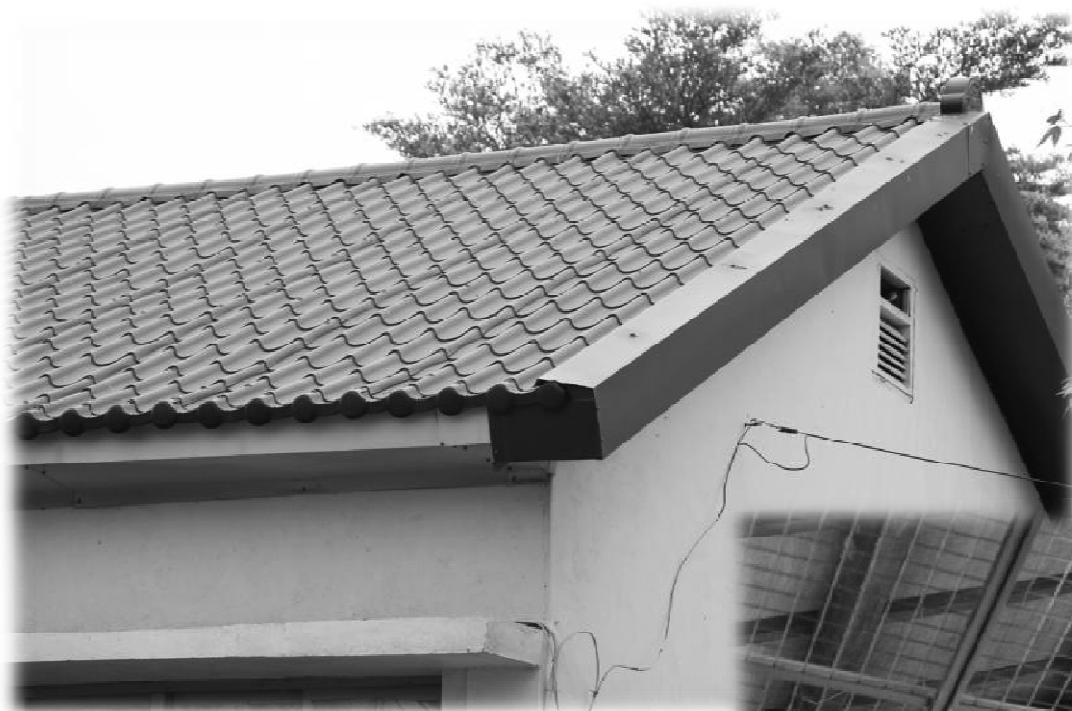
北棟舊教室-屋頂外觀
